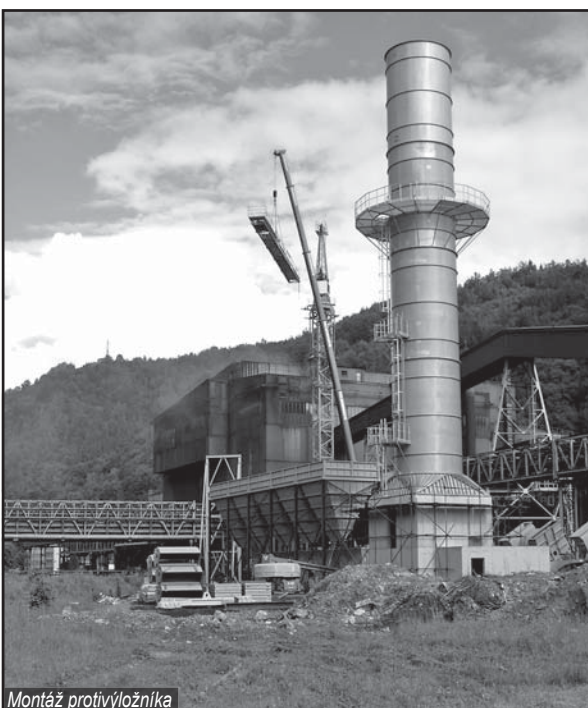
Montáž protivýložníka
