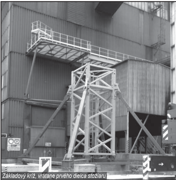
Základový kríž, vrátane prvého dielca stožiaru
