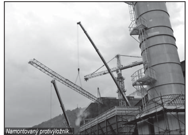
Namontovaný protivýložník...
