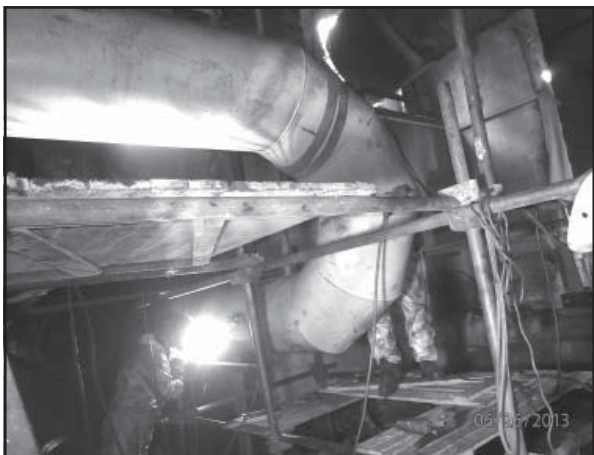
Výmena a montáž časti potrubia pre odvedenie okujovej vody do hydrocyklónu
