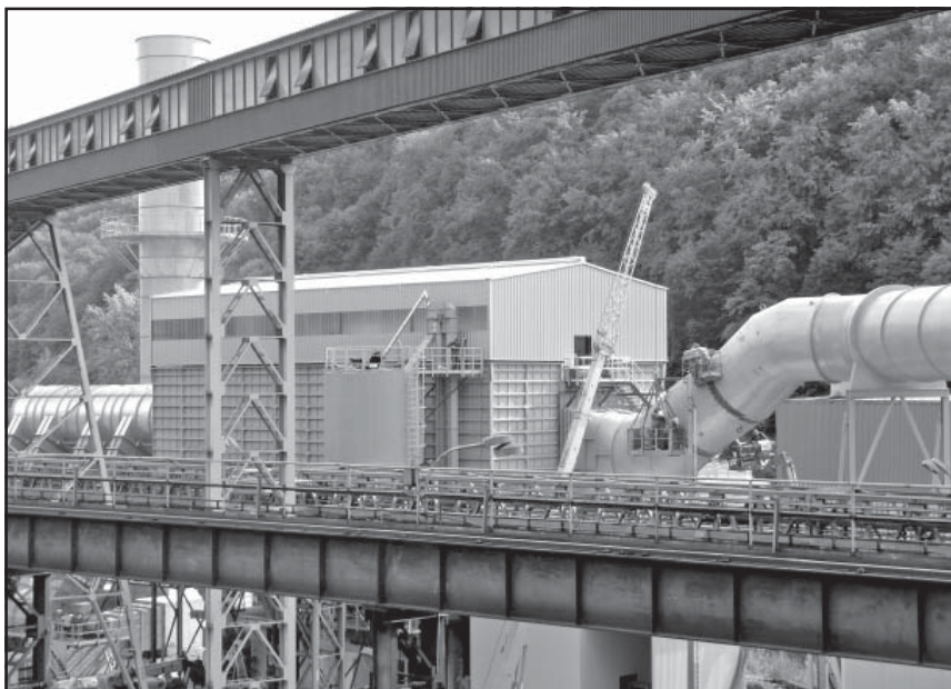
Nové odprášenie - vlastná filtračná stanica s peletizačnou linkou je zmontovaná, úpravy na streche EAF s jej uzatvorením sú ukončené, vodou chladené potrubie s dospelovacou komorou je zmontované a otlakované. Výmenníková stanica, ako aj ostatné technológie, sú momentálne uvádzané do prevádzky. Foto: Anna Nociarová
