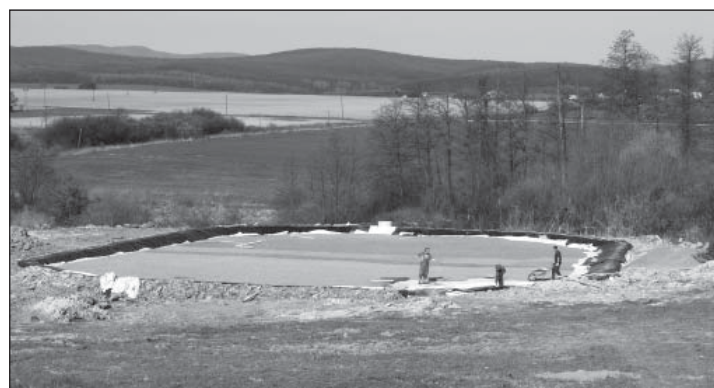
Sanácia miesta uloženia odpadov z výroby generátorového plynu
