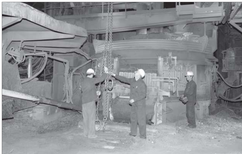
Pred strednou opravou.
