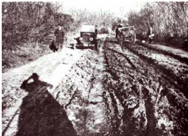
Z výstavby úseku južnej magistraly pri Senohrade, ktorý následne pokračoval smerom Oremlaz – Stará Huta a Podkriváň, ktorý stavali štátne železiarne v Podbrezovej
