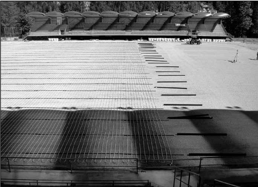
Montáž vykurovania, rozšírená severná tribúna, zatiaľ bez sedačiek. F: Ing. L. Schwarzbacher
