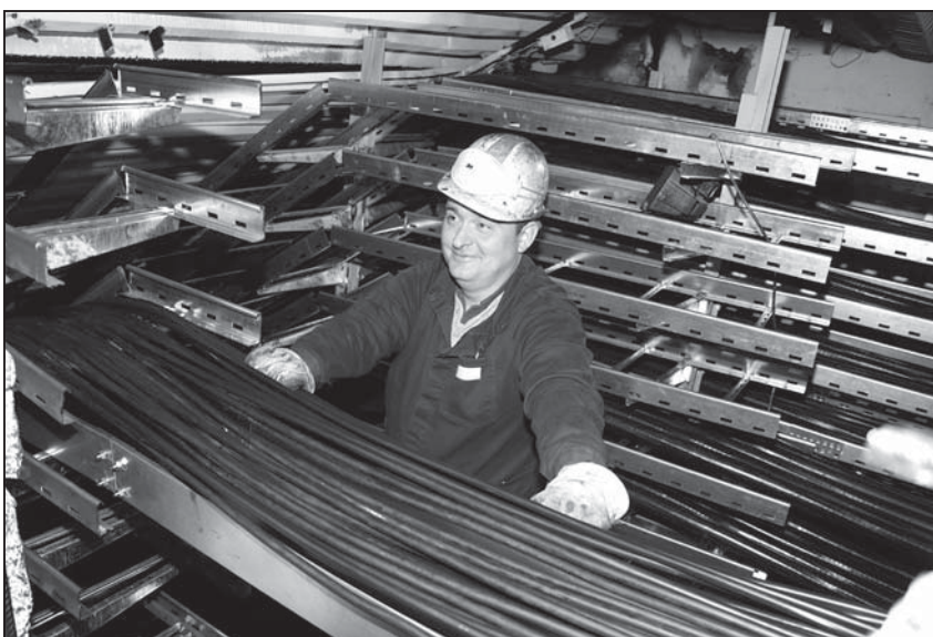
Ľubomír Hlásnik z redukovne Vvr pri tahaní káblov v elektrokanáli Ivan.
