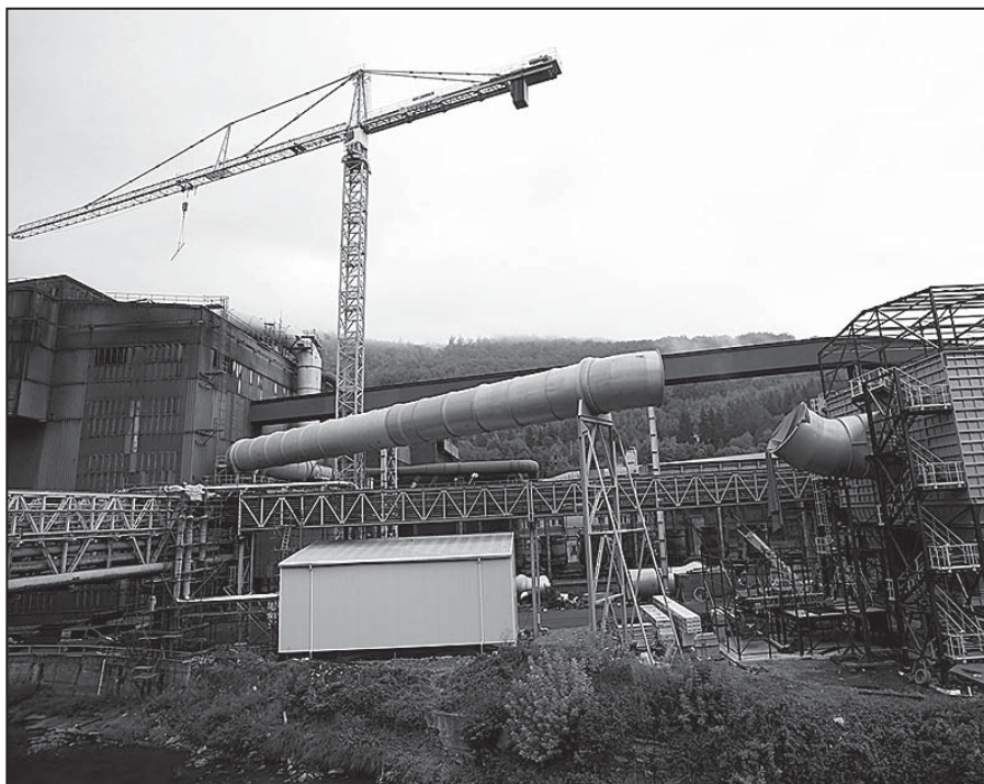
Odprášenie EAF, LF - montáž hlavného radu potrubia na strechu haly a montáž ocelevej konštrukcie strechy filtračnej stanice.
