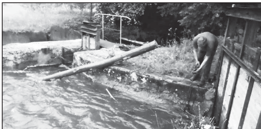
Odstraňovanie doplavených kmeňov stromov, konárov a odpadu na hatí v Mýte pod Ďumbierom.
