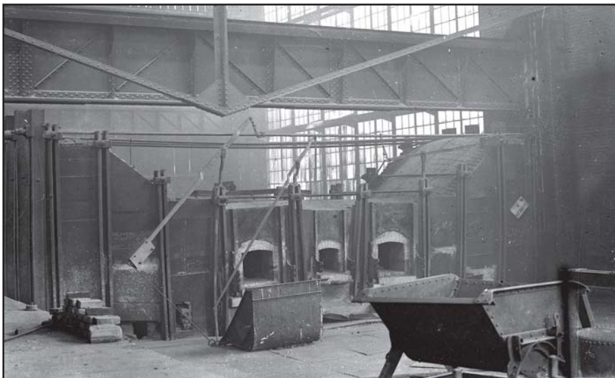
Prestavba siemens-martinskej pece číslo 4.
