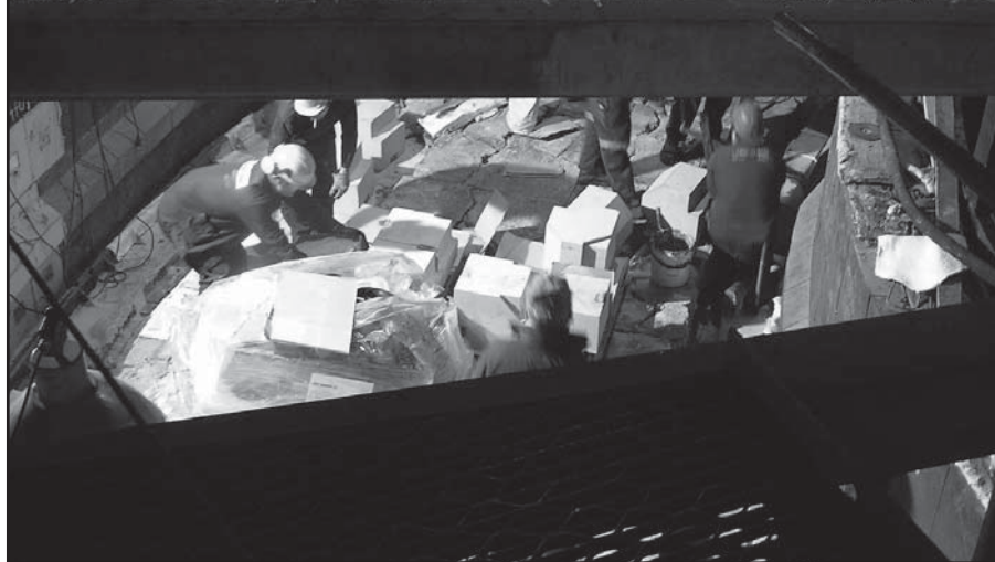
Pohľad do priestoru karuselovej pece pri kladení nových vonkajších a vnútorných obrubníkov.
