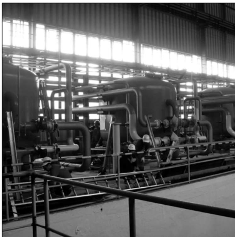
Montáž pieskových filtrov sekundárneho okruhu Foto: Ľubor Schwarzbacher
