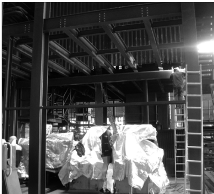
Montáž oceľovej konštrukcie pre miestnosť hydrauliky
