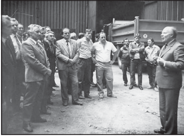
Pred slávnostným výkopom výstavby novej elektrooceliarne. Prvá sprava Ing. Anton Štulrajter, podnikový riaditeľ. Foto: archív HM ŽP
